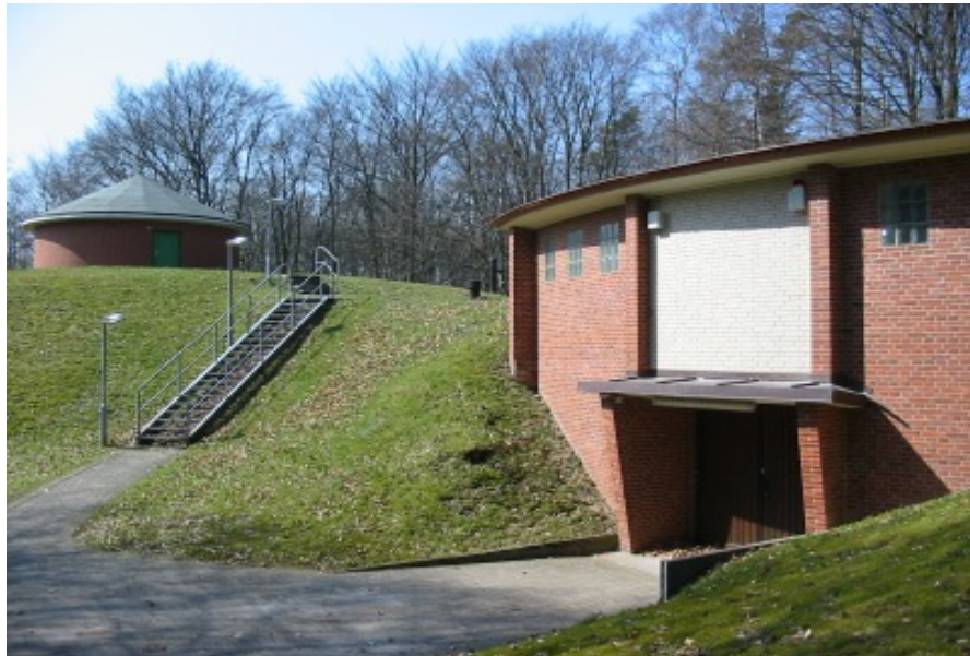
Hochbehälter Langenrehm auf dem Gannaberg, gebaut 1973
