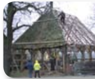
Abbau der Scheune in Handorf
